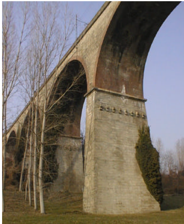
Figura 2 Pila di viadotto, viadotto Pesio – linea Fossano-Ceva, progr. 14+200 (Archivio FS-TO)
