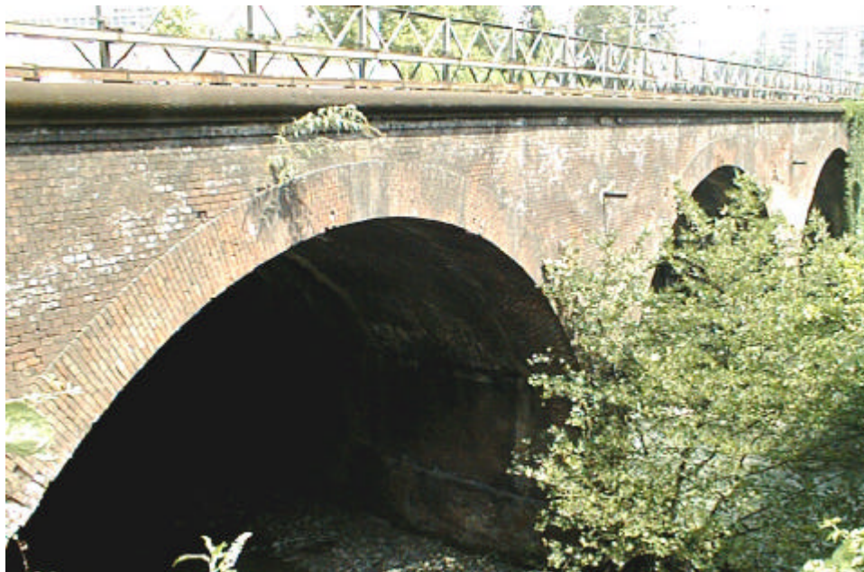
Figura 15 Muro andatorio o timpano. Si osservi il coronamento in pietra a taglio (ponte Dora - linea Torino-Milano, progressiva 5+915 – Archivio FS-TO).
