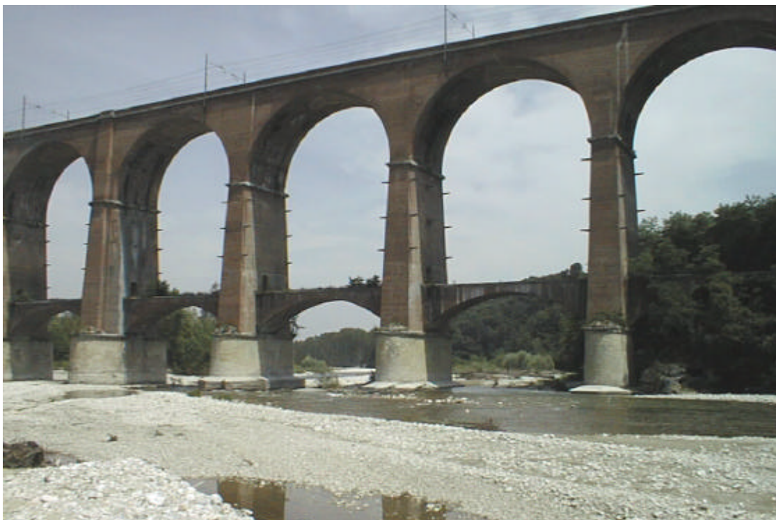
Figura 7 Viadotto Stura - linea Fossano-Ceva, progr. 2+606 (Archivio FS-TO).
